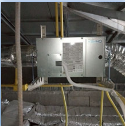
ภาพการติดตั้งบนฝ้า
